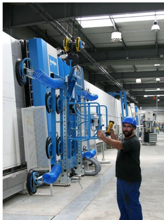
Ligne de fabrication de vitrages isolants
