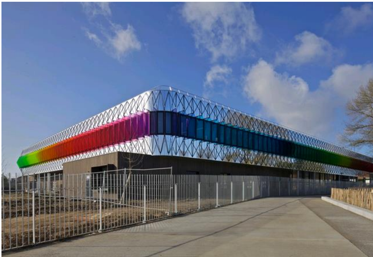
Réalisation du vitrage feuilleté du collège Anne de Bretagne - Sotraver remporte le Vanceva World of Color Award en 2014 - Brises soleil feuilletés trempés 10-10/4 HST - 230 volumes de 23 couleurs différentes.
